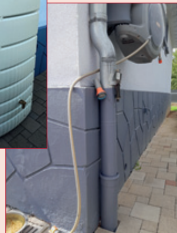
Exemples de déaccordement et mise en place de cuve de récupération des eaux pluviales
