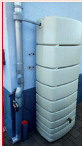
Exemples de déaccordement et mise en place de cuve de récupération des eaux pluviales
