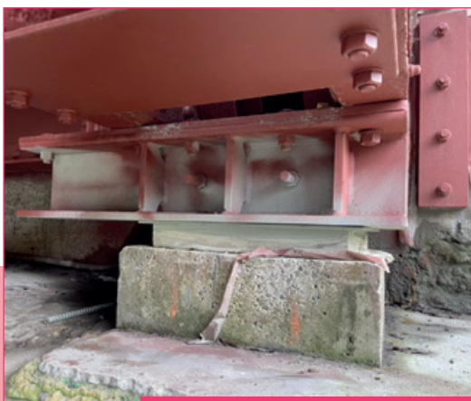
Réparation des appareils d'appuis et traitement anti-corrosion
