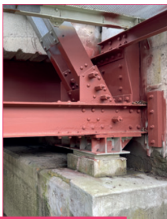
Réparation des appareils d'appuis et traitement anti-corrosion
